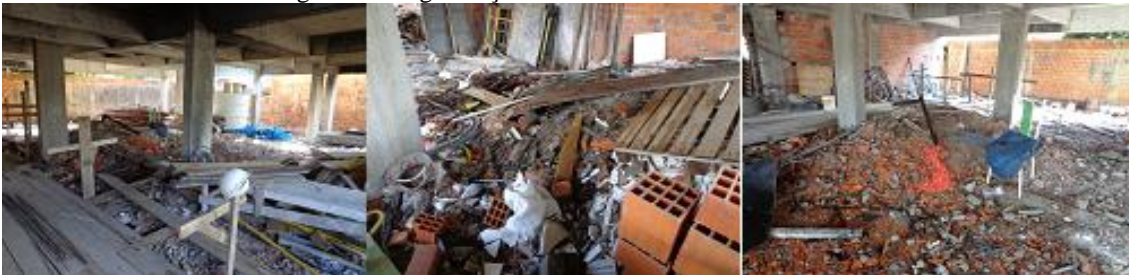
Figura 2 – Organização encontrada no canteiro de obra
