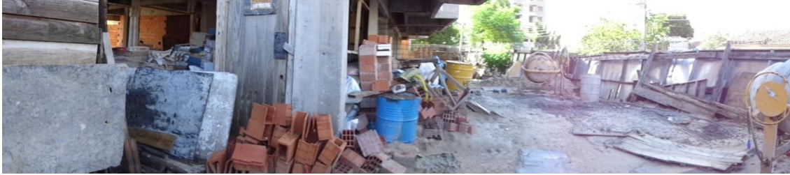
Figura 1 – Primeira vista do canteiro de obras
