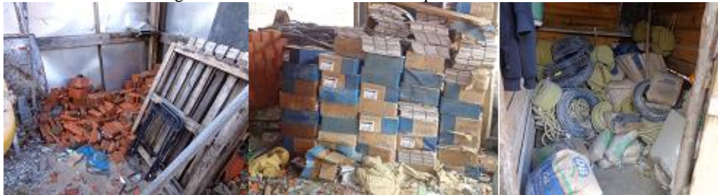
Figura 5 – Condicionamento inadequado dos materiais
