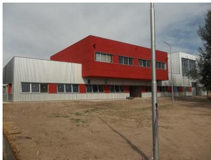
Fig 1. Vista exterior de edificio
